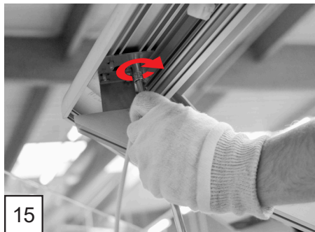
Przykręcenie profili lamp
