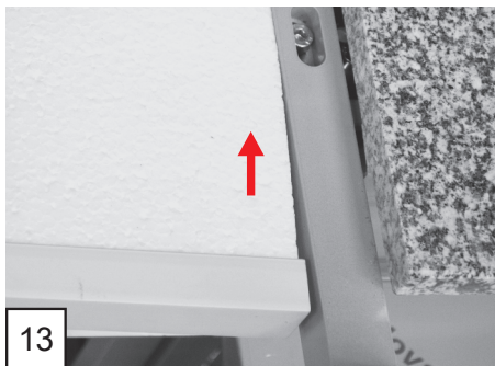
13 Założenie izolacji pod blat roboczy
